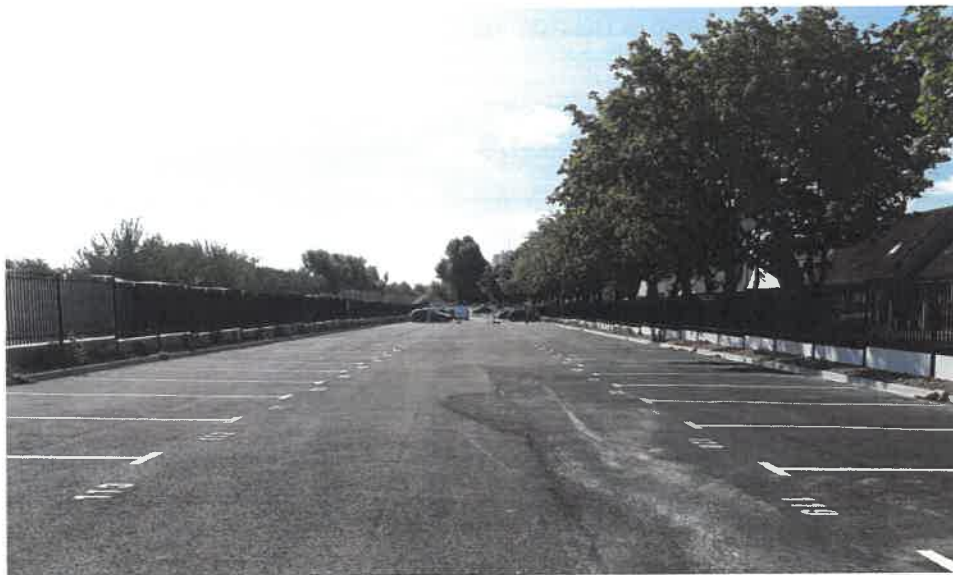
Places de stationnement sur le parking réaménagé par l'Expropriant sur l'emprise des parcelles AZ 75 et AZ 76
